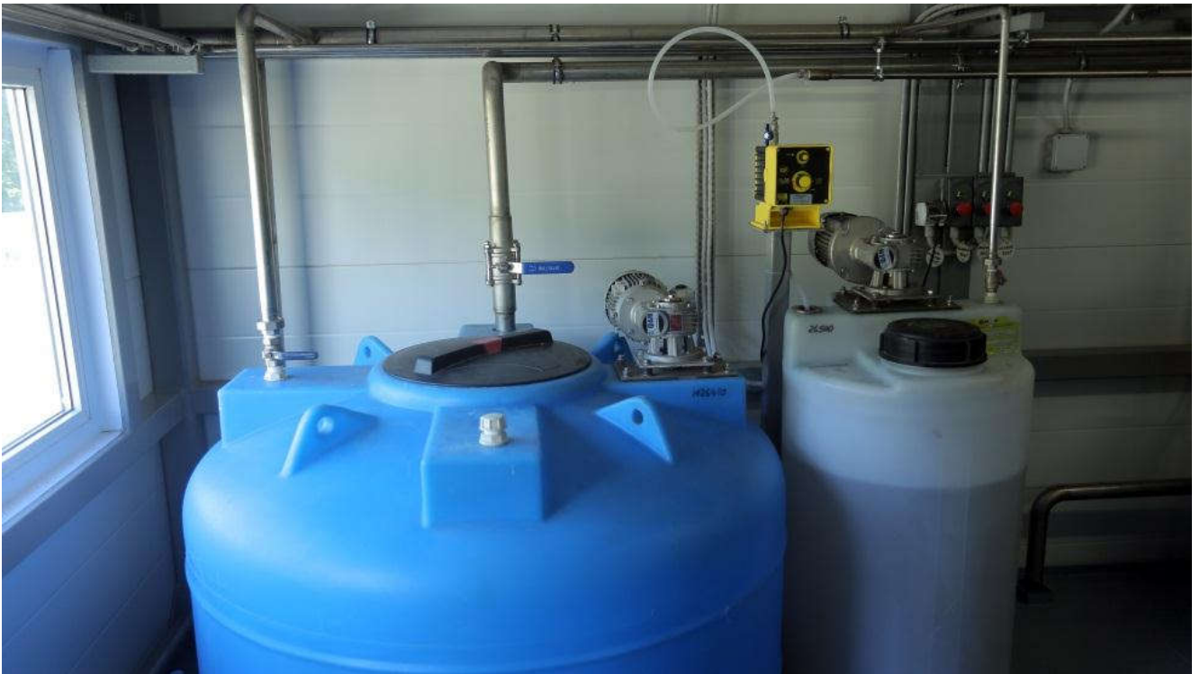
Узел приготовления раствора промывки и регенерации обратноосмотических мембран
